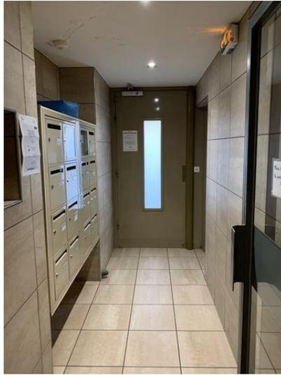
Le tout est propre. Cependant, je constate la présente une trace de dégât des eaux à l'aplomb des boîtes aux lettres.
